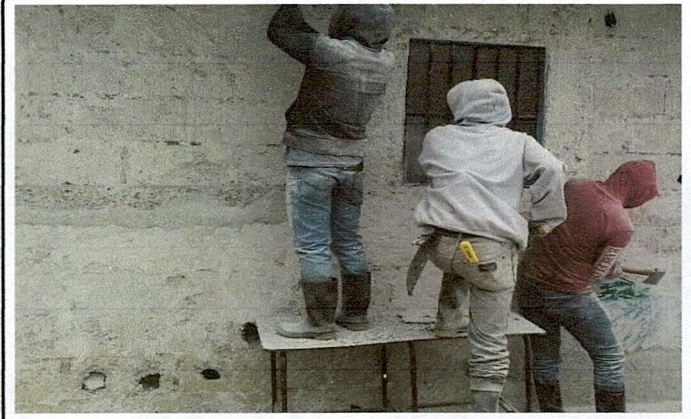
Foto 2: vista interna del modulo 1, En mejoramiento
